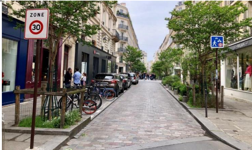
Αλλαγή υφής στο σύνολο του οδοστρώματος
